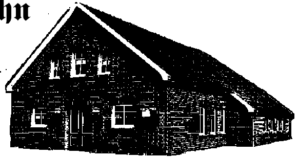
Vehnhus Beningafehn, van-Louwerman's-Stee, Bahnhofstr. 32 a www.vehnhus-beningafehn.de
